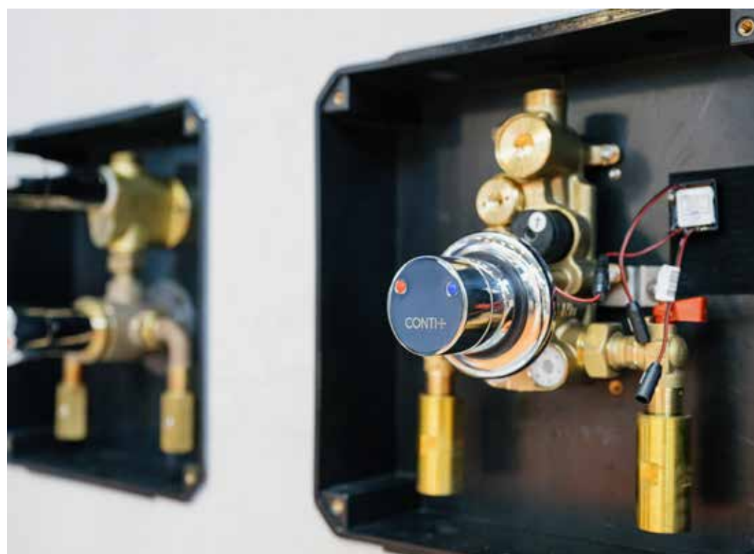
Links mechanische Wasserstecke, rechts Umrüstung auf elektronisch.
